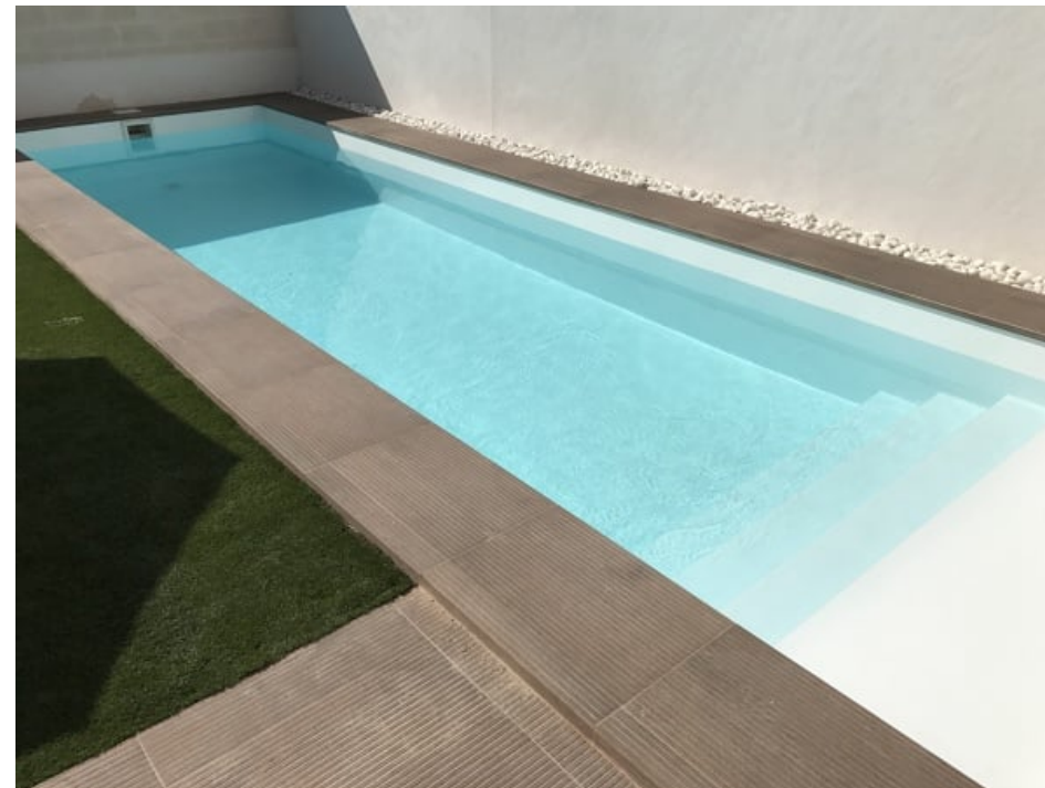
PISCINA CON PLAYA Y ESCALERA DE OBRA
